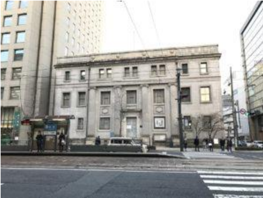
Bild 1: Gebäude der Bank of Japan in Hiroshima. Bis auf den Glasbruch von der "Atombombe" war das Haus nicht beschädigt, und dies trotz einer Entfernung von 500 Meter zu Ground Zero!
