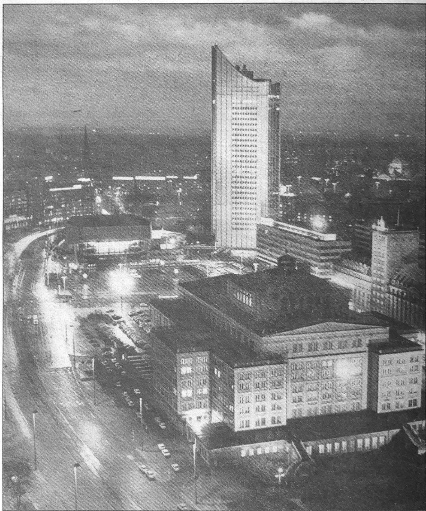
DAS HÖCHSTE HAUS IN DER DDR ist mit 143 m das Hochhaus der Karl-Marx-Universität im Stadtzentrum von Leipzig.
