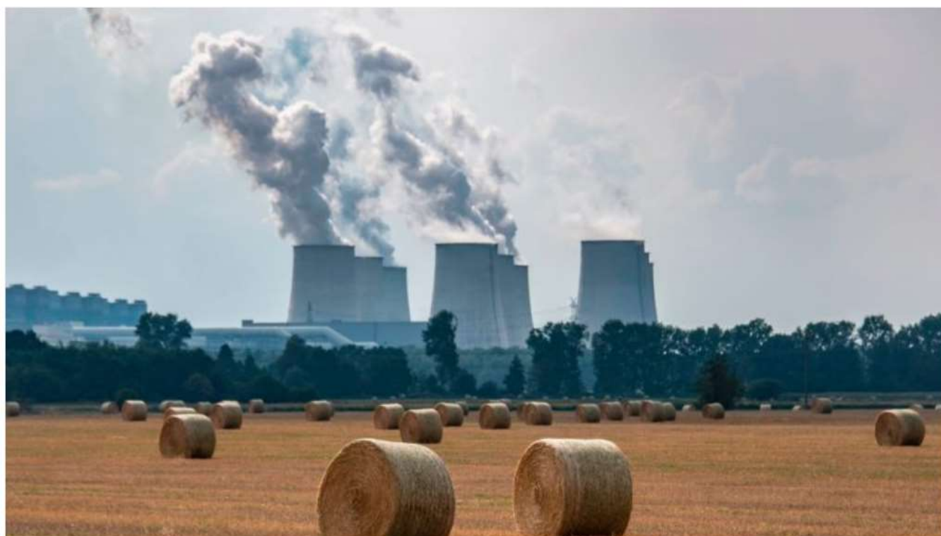
Vor dem Kraftwerk Jaenschwalde bei Peitz am 30. Juli 2019. Das drittgrößte Braunkohlekraftwerk Deutschlands, das zwischen 1976 und 1988 in der DDR gebaut wurde, wird von der Lausitz Energie Kraftwerke AG (LEAG) betrieben. Foto: JOHN MACDOUGALL/AFP/Getty Images
