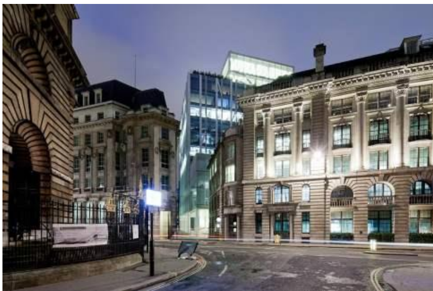
New Court in der St. Swithin's Lane: Der Stammsitz der weltgrößten Privatbank N.M. Rothschild & Sons
